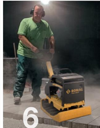
kraft von ca. 300 kg bzw. ein Vakuum-Verlegegerät. Es müssen immer Steine aus mindestens 3 Paletten gleichzeitig gemischt werden, mehr ist besser. Ein lagenweises Verlegen kann zu ungewünschten Farbverläufen auf der Fläche führen. Deshalb ist auch das vertikale Mischen von den Paletten herunter wichtig!
