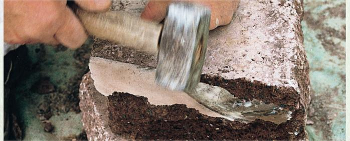
Nach dem maßgerechten Zuschnitt der Mauerblöcke können die Schnittflächen auf einfache Weise mit einem Fäustel oder Bossierhammer nachbearbeitet werden.
