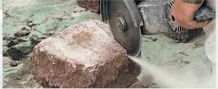
Zeichnen Sie die Steine gemäß dem gewünschten Kurvenradius an und schneiden ihn mittels Trennscheibe. Bitte achten Sie auf das Tragen geeigneter Schutzausrüstung.
