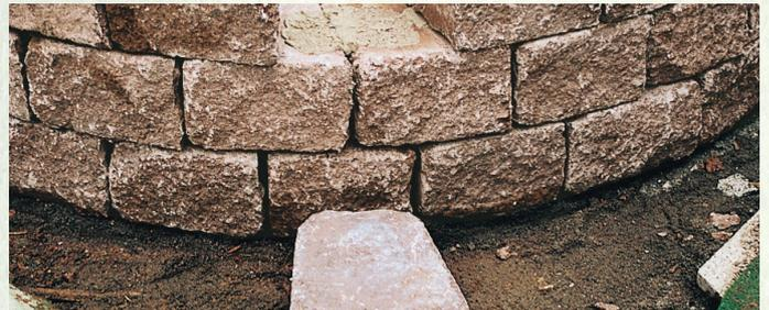
Der Zuschnitt ermöglicht nun einen passgenauen Einbau des Steins.
