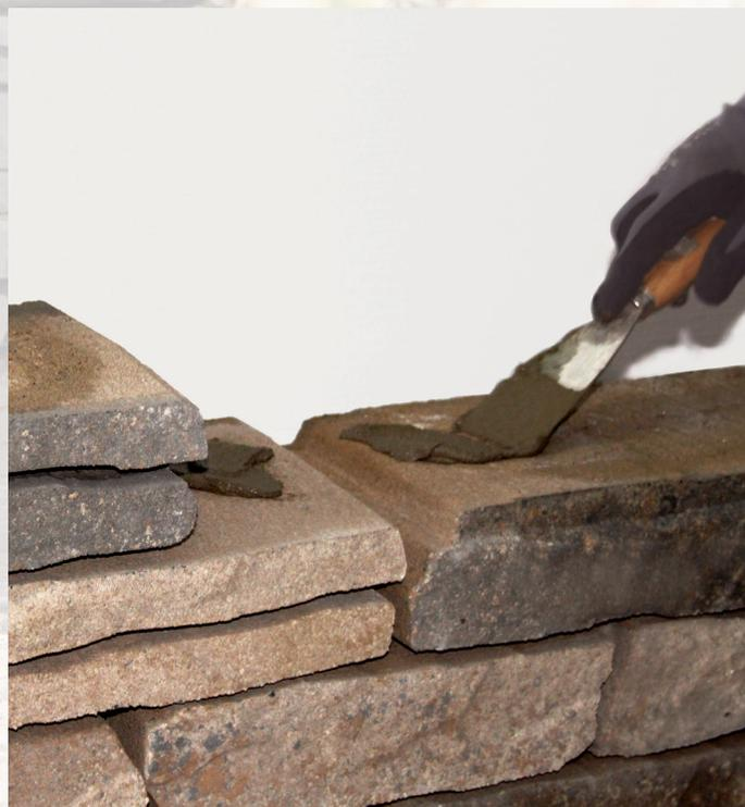
Nach Fertigstellung der letzten Steinlage werden die oben liegenden Platten mit dem Beton- bzw. Naturstein-Flexkleber befestigt.
