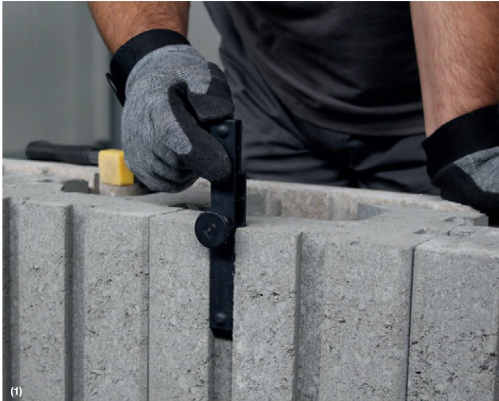
*Sie sorgen nicht nur für die Verbindung zwischen den einzelnen Basissteinen, sondern dienen gleichzeitig als Abstandshalter bei einem Versatzaufbau und auch als sogenannte Verbinder zwischen Basisstein und Verblender.*
