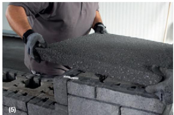
während der Montage mit punktuell etwas dicker aufgetragenem Kleber ausgeglichen werden. Bitte beachten Sie das genaue Vorgehen bei der Fundamentausbildung und dem Versetzen der Basissteine - wird in diesen Schritten exakt gearbeitet, ist das Endergebnis und ein gerader Abschluss ein Leichtes und lässt kaum „Spiel“ zu, welches ggf. ausgeglichen werden müsste.
