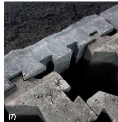
**Beim Schneiden der Verblender ist essenziell, dass Sie immer im Rastermaß von 6,7cm schneiden.** Als Merkhilfe gilt:
