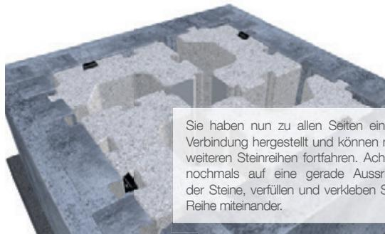
Sie haben nun zu allen Seiten eine feste Verbindung hergestellt und können mit den weiteren Steinreihen fortfahren. Achten Sie nochmals auf eine gerade Ausrichtung der Steine, verfüllen und verkleben Sie jede Reihe miteinander.
