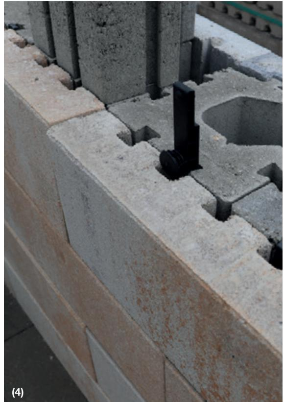
Nutzen Sie hier für die rückseitige Verblender die mitgelieferten Steckverbinder (Abb.1. Steckverbinder in **rot** gekennzeichnet). Die Anordnung der Verblender gibt Ihnen die Position der Steckverbinder vor.
