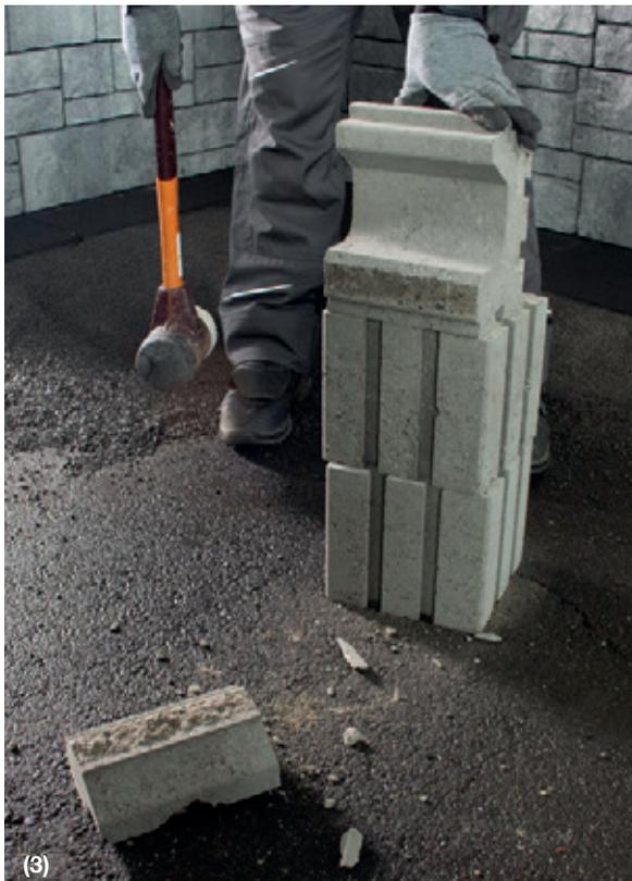
Achten Sie bei der Herstellung eines Passsteins darauf, dass die Sollbruchstelle mit der Oberkante Ihrer stabilen Auflage bündig abschließt. So stellen Sie sicher, dass die Sollbruchstelle nicht ausbricht. Nun können Sie Ihren Passstein in Ihren Aufbau einsetzen (4).
