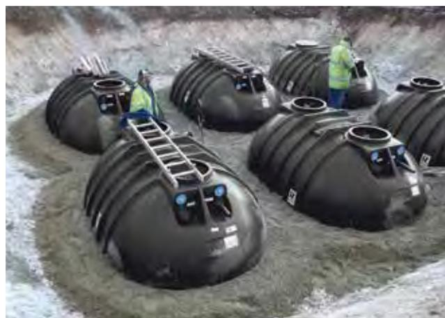
**Einbaubeispiel:** Großanlagen mit mehreren BlueLine Rundtanks a 10.000 Liter.
