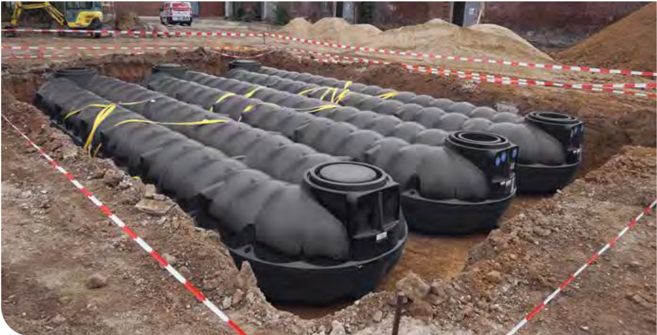
Einbaubeispiel: 60.000 Liter Anlage mit drei Regenwassertanks NEO a 20.000 Liter
