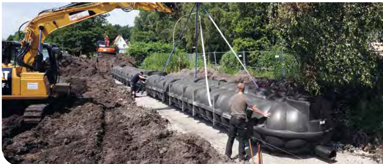
Einbaubeispiel: Retentionsanlage NEO 4 x 25.000 Liter
