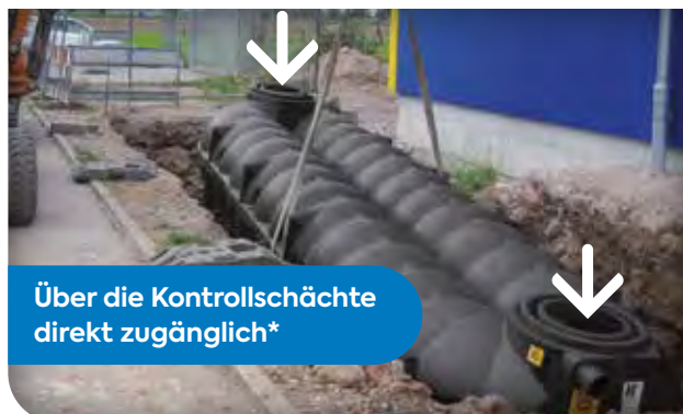
Einbaubeispiel: Versickerungsrigole NEO 15.000 Liter
