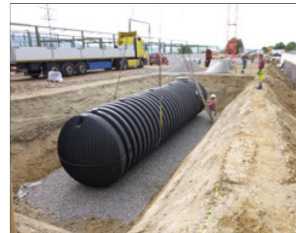
Der Kunststofftank GRAF Carat XXL wurde mit einem Autokran „in einem Stück“ eingebracht und in Kies eingebettet. Die für das Versetzen des Regenspeichers erforderlichen Hebeschlaufen waren bereits im Lieferumfang enthalten.
