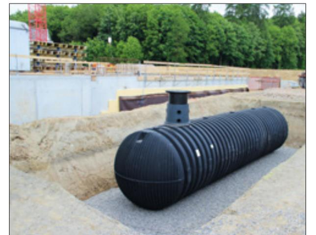
Die Konstruktion des Behälters sorgt für hohe Stabilität und ermöglicht so den Einbau bis zur Tankmitte in das Grundwasser. Der Carat XXL ist für eine Lkw-Befahrbarkeit mit bis zu 40 t Gesamtgewicht ausgelegt.
