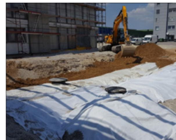
Die Aushubarbeiten der Grube, die Herstellung des Kiesbetts und der lastverteilenden Platte wurden an 5 Arbeitstagen ausgeführt.
