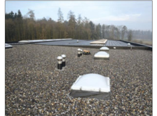
Die für die Regenwassernutzung benötigte Dachfläche von 2.500 m<sup>2</sup> ist mit Kies bedeckt.
