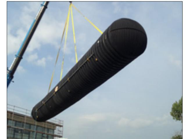
Innerhalb von nur zwei Stunden wurden die beiden Tanks von dem Lkw in die Grube gehoben.
