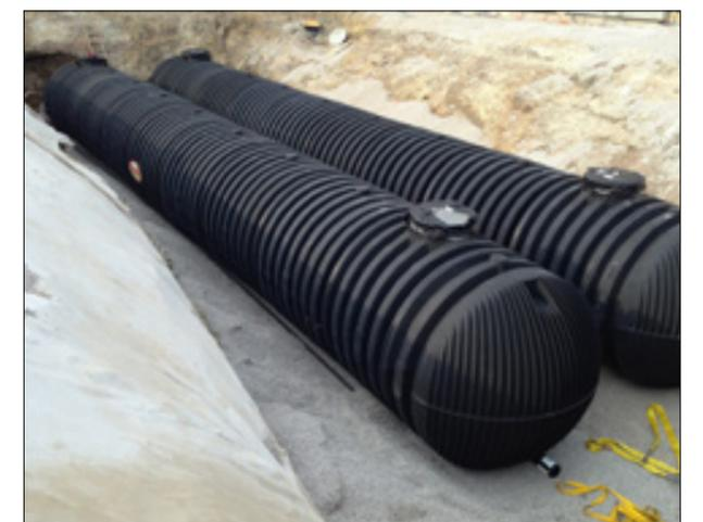
Die GRAF Erdtanks benötigen trotz einer Lkw-Überfahrbarkeit bis 40t nur eine Überdeckung von 1m bis zur Geländeoberkante.
