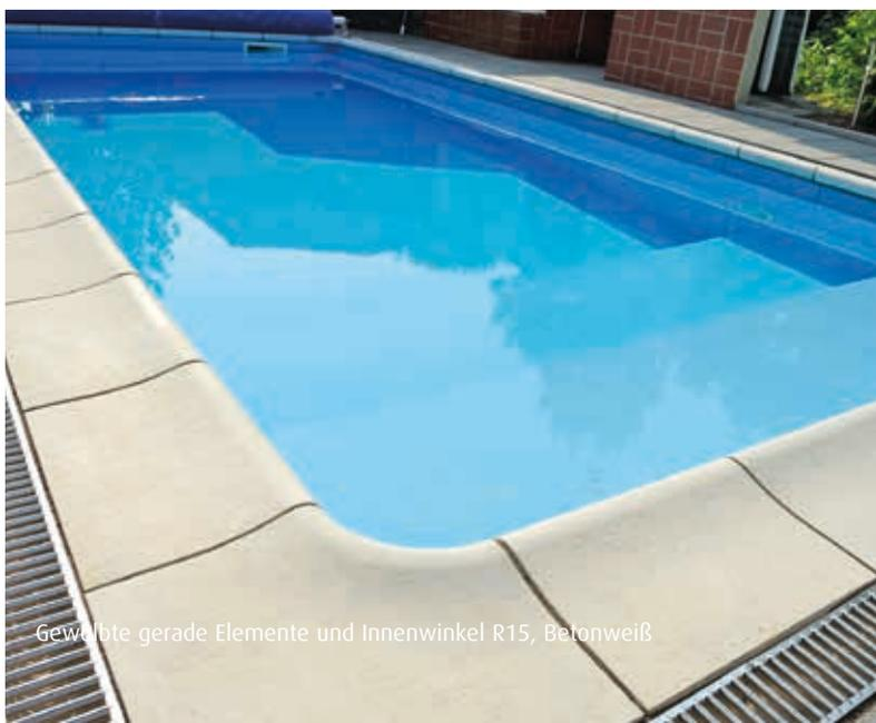
Gewölbte gerade Elemente und Innenwinkel R15, Betonweiß
