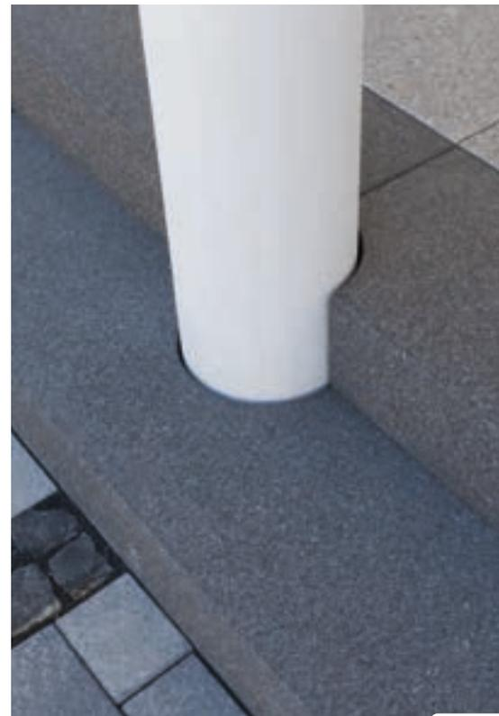
Ob Regenfallrohr, Putzversprünge, Dachstützen oder Aussparungen für die Haustür. Unser Service nimmt das genaue Maß vor Ort und wir fertigen das jeweilige Bauteil mit maßgenauer Aussparung für Sie an.
