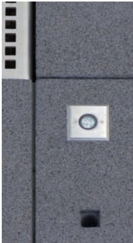
**itstein** ist nicht nur ein eindrucksvolles Mittel zur Gestaltung, es sorgt auch für Sicherheit. Stufen, Pflaster, Platten, Podeste und Mauerteile können bei Rinnabwerk mit den passenden Aussparungen für energiesparende **LED**-Leuchtelemente versehen werden. So passt die Beleuchtung perfekt ins Bild.
