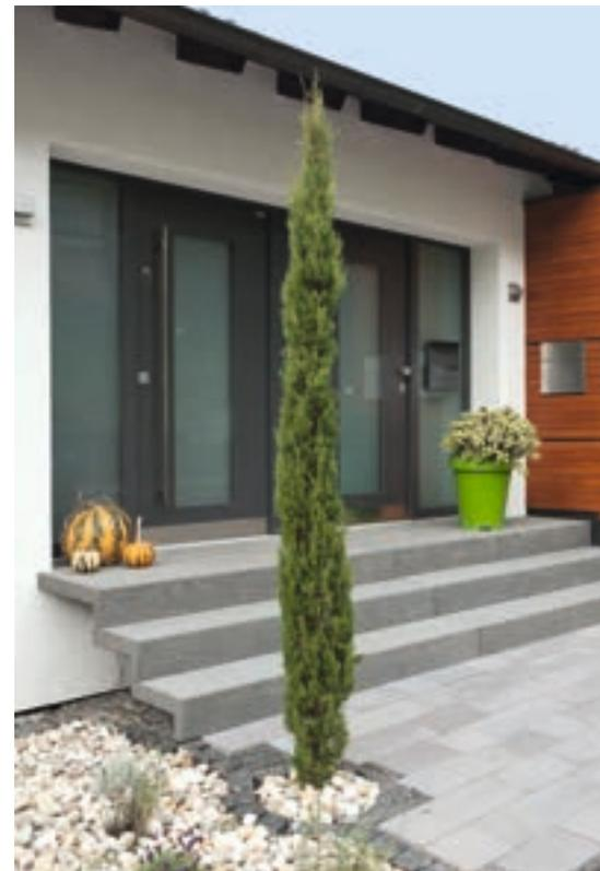
**Winkelstufen** werden entweder freitragend auf Treppenbalken oder auf einem Betonfundament verbaut. Beide Anwendungsfälle sind entweder als Neubau freigestaltbar oder auch als Sanierung perfekt an den vorhandenen Baugrund anzupassen. Eine eventuell offen gestaltete Treppenseite zeigt die filigrane Optik von Winkelstufen.
